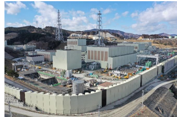
工事が進む海拔29mの防潮堤
