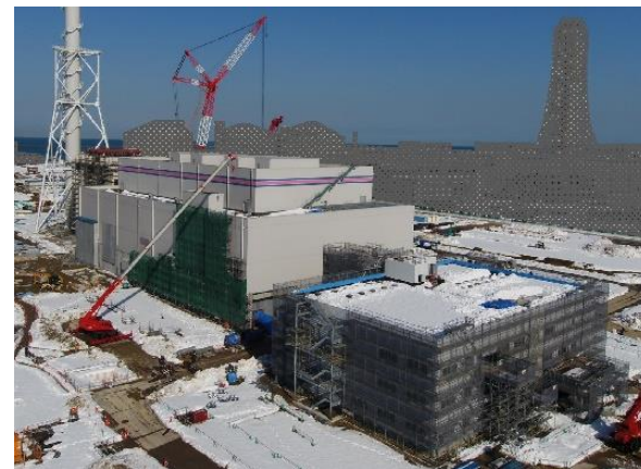
上越火力発電所1号機の 建設工事の様子 (2021年1月現在)
