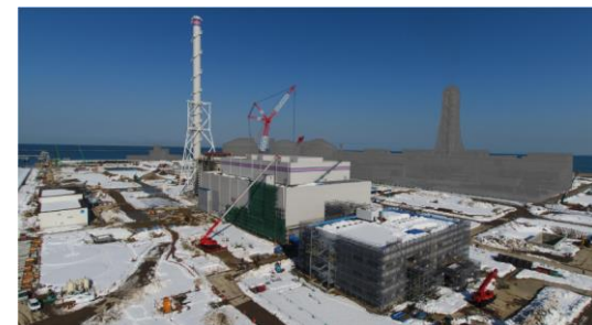
〔上越1号・建設工事中〕
