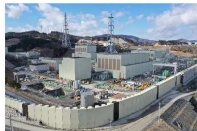
工事が進む海拔2.9mの防潮堤
