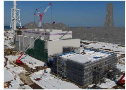
上越火力発電所1号機の 建設工事の様子 (2021年1月現在)
