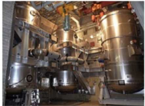
原子炉格納容器圧力逃がし装置（工事中）
