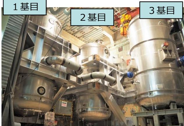
原子炉格納容器圧力逃がし装置（フィルタベント系）の設置作業（2019年2月までに2基のフィルター装置の据付が完了。現在は3基目の据付作業を実施中）
