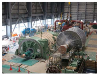
タービン建屋 発電機、タービン組立状況
