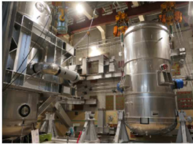
2018年8月に行われた原子炉格納容器圧力逃がし装置(フィルタベント系)の設置作業
