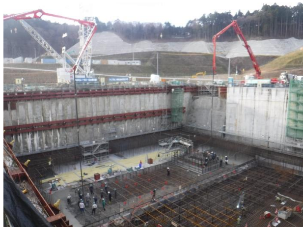
緊急時対策建屋のコンクリート打設作業
