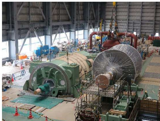
タービン建屋 発電機、タービン組立状況
