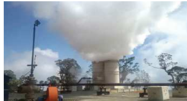
蒸気噴気試験の様子 (ランタウ・デダップ地熱発電事業開発地点)
