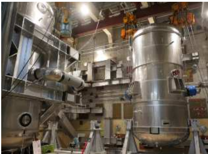
2018年8月に行われた原子炉格納容器圧力逃がし装置(フィルタベント系)の設置作業
