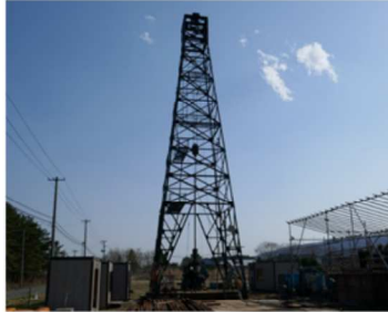
補足調査（地質確認のためのボーリング調査作業（地下深部の土を採取し、直接地質の状態を確認する））
