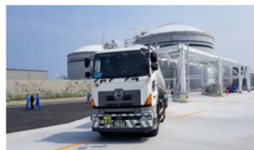
新仙台火力発電所のLNG出荷設備
