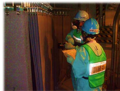
プラント起動時の 格納容器内確認
