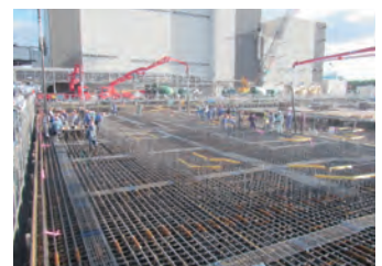
能代火力発電所3号機基礎工事でのコンクリート大量打設の状況
