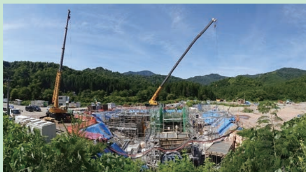
玉川第二発電所建設の様子
