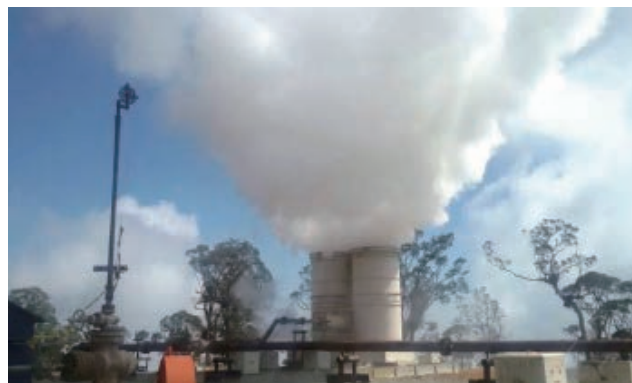
蒸気の噴気試験の様子
