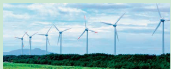
能代風力発電所
