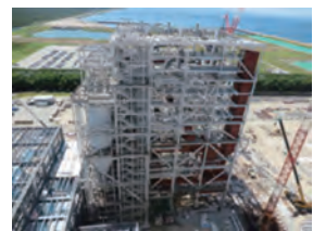
能代火力発電所3号機建設工事状況 (ボイラー設備工事)
