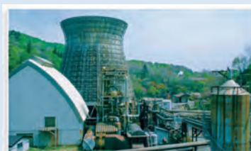
松川地熱発電所
