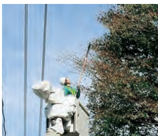
配電線保守作業などに伴う伐採
