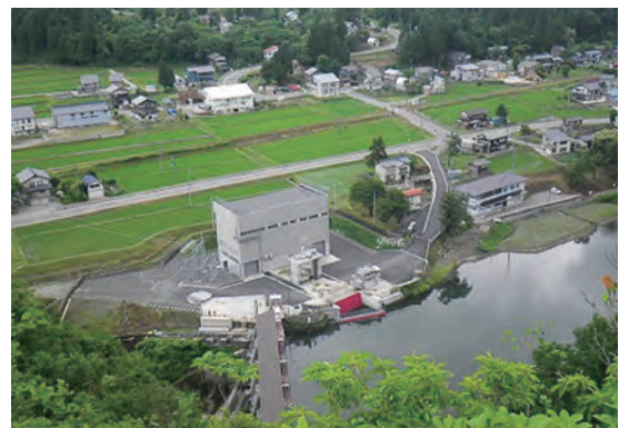
第二蕨神発電所
