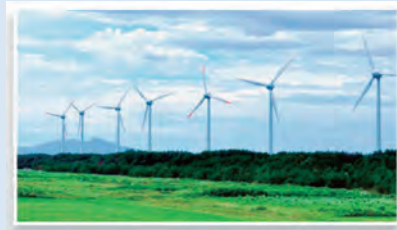
能代風力発電所
