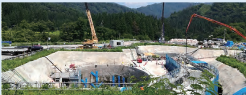
玉川第二発電所建設の様子
