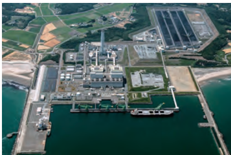
原町火力発電所
