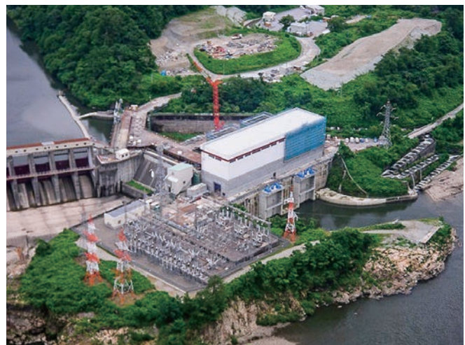
リニューアル工事が進む鹿瀬発電所（新潟県阿賀町）
