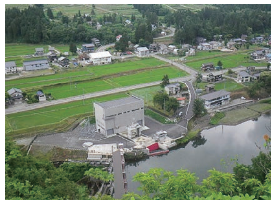
第二荻神発電所(新潟県魚沼市)
