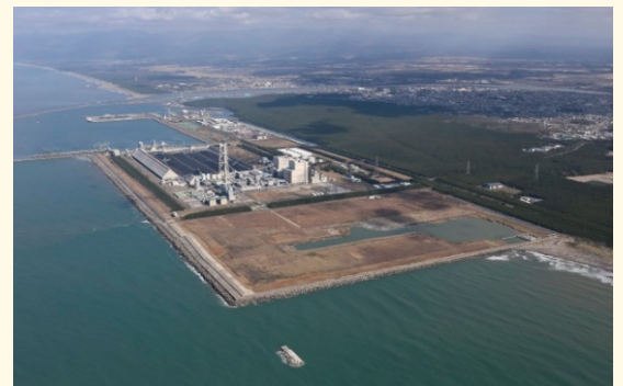
能代火力発電所3号機建設予定場所 (秋田県能代市)
