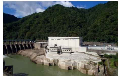
リニューアルした豊実発電所（新潟県阿賀町）
