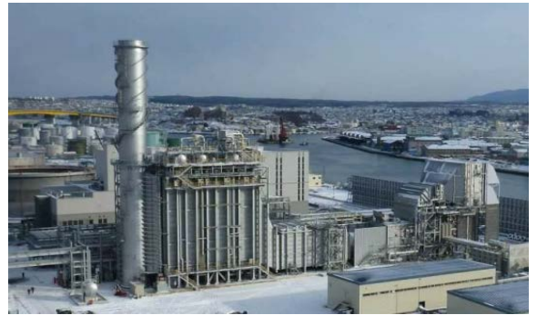
八戸火力発電所5号機（青森県八戸市）
