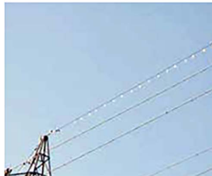
送電線への標識設置状況
