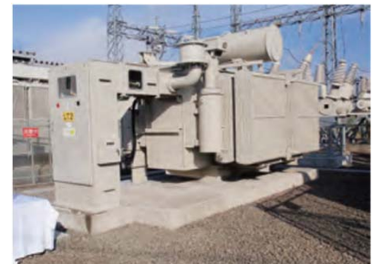
梁川変電所に導入された環境調和型変圧器（福島県伊達市）
