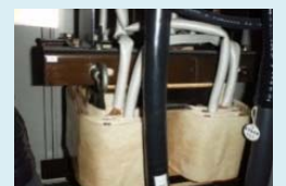
絶縁油を使用しない乾式の変圧器
