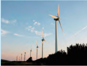
能代風力発電所
