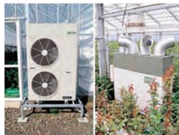
施設園芸用ハウスへのヒートポンプ導入事例 (宮城野バラ工房梶農園 様)
