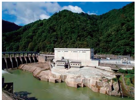
リニューアルした豊実発電所（新潟県阿賀町）
