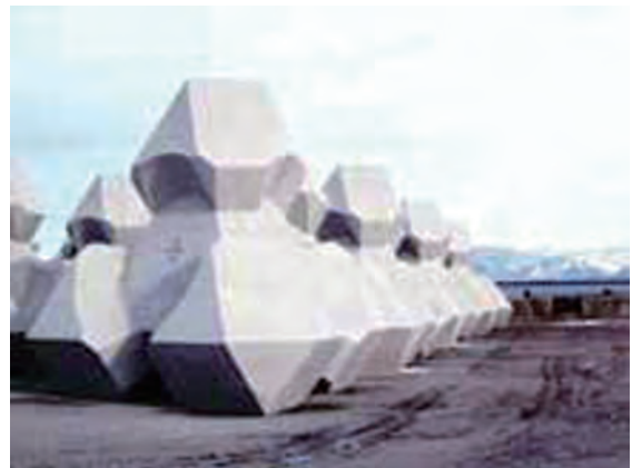
フライアッシュ混合コンクリートで製造された消波ブロック
