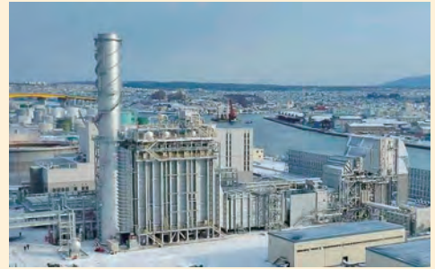
八戸火力発電所5号機（青森県八戸市）
