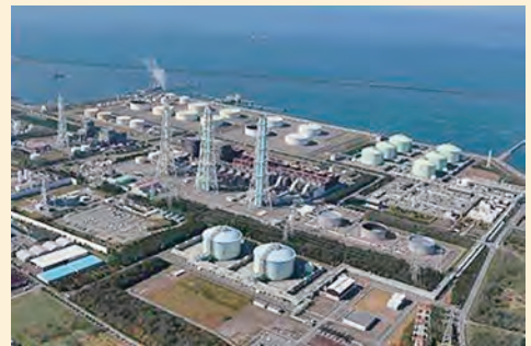
東新潟火力発電所（新潟県聖籠町）
