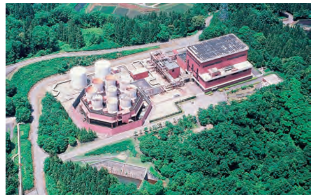
単機として国内最大出力を誇る柳津西山地熱発電所 (最大出力6万5,000kW／福島県柳津町)
