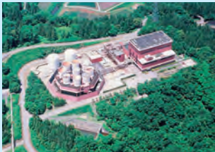
柳津西山地熱発電所
