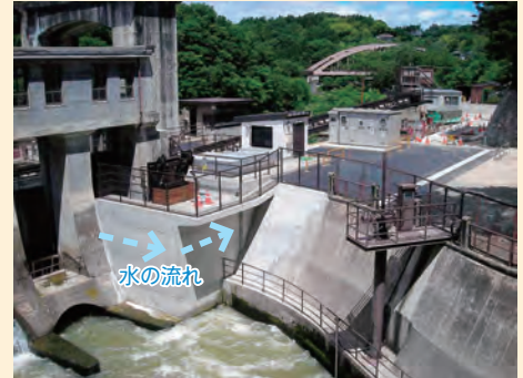
2014年6月に営業運転を開始した飯野発電所 (福島県福島市)
