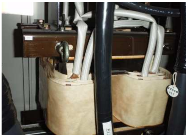
絶縁油を使用しない乾式の変圧器
