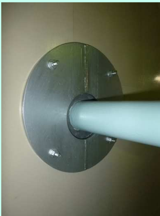
貫通部の止水処理
