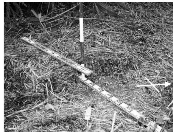
写真-1 尾根部で確認された13cmの段差 写真位置は図-4参照。
