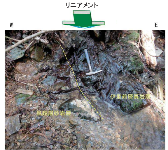
写真A スケッチ箇所露頭の現状
