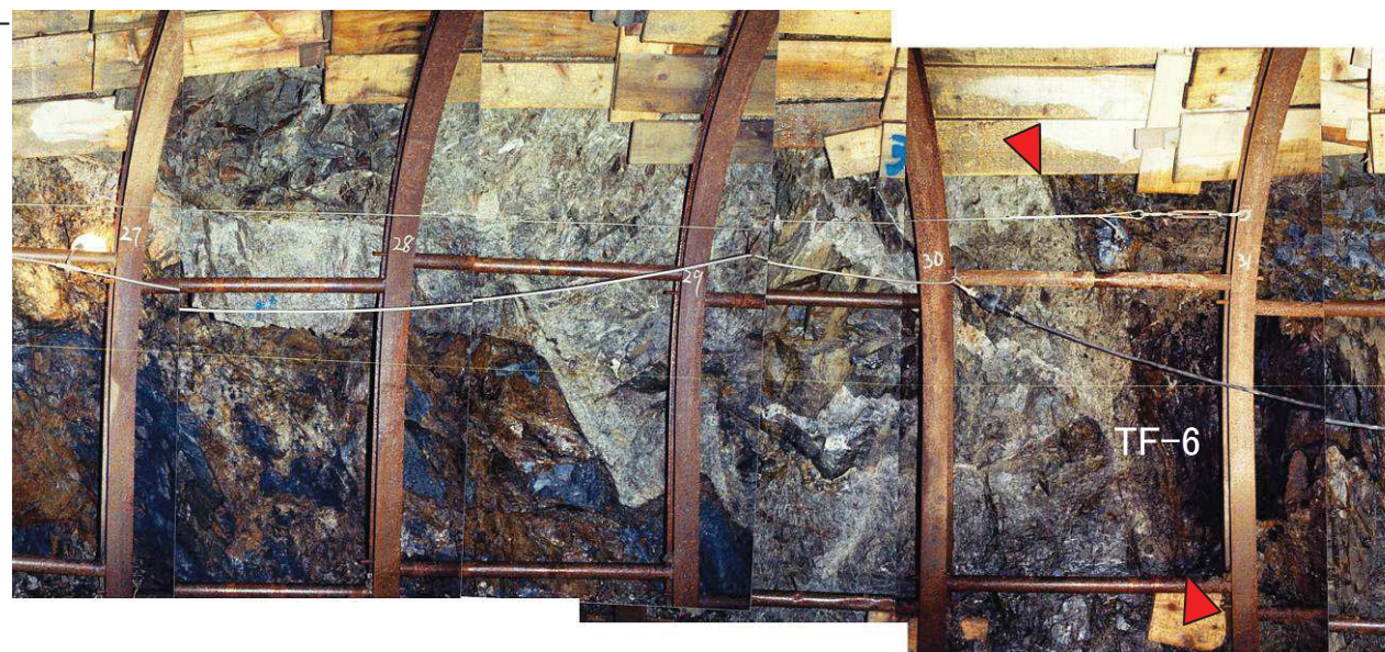
TF-6断層 3号炉試掘坑2号坑南東壁写真
