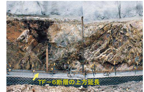
直掘部最上段の TF-6断層延長部
