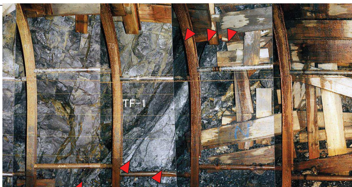
TF-1断層 3号炉試掘坑2号坑北西壁写真
