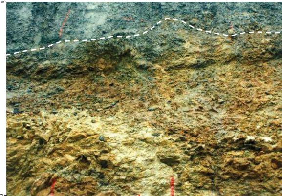
第四系基底面の状況 (南側法面: 追い込み掘削前)
