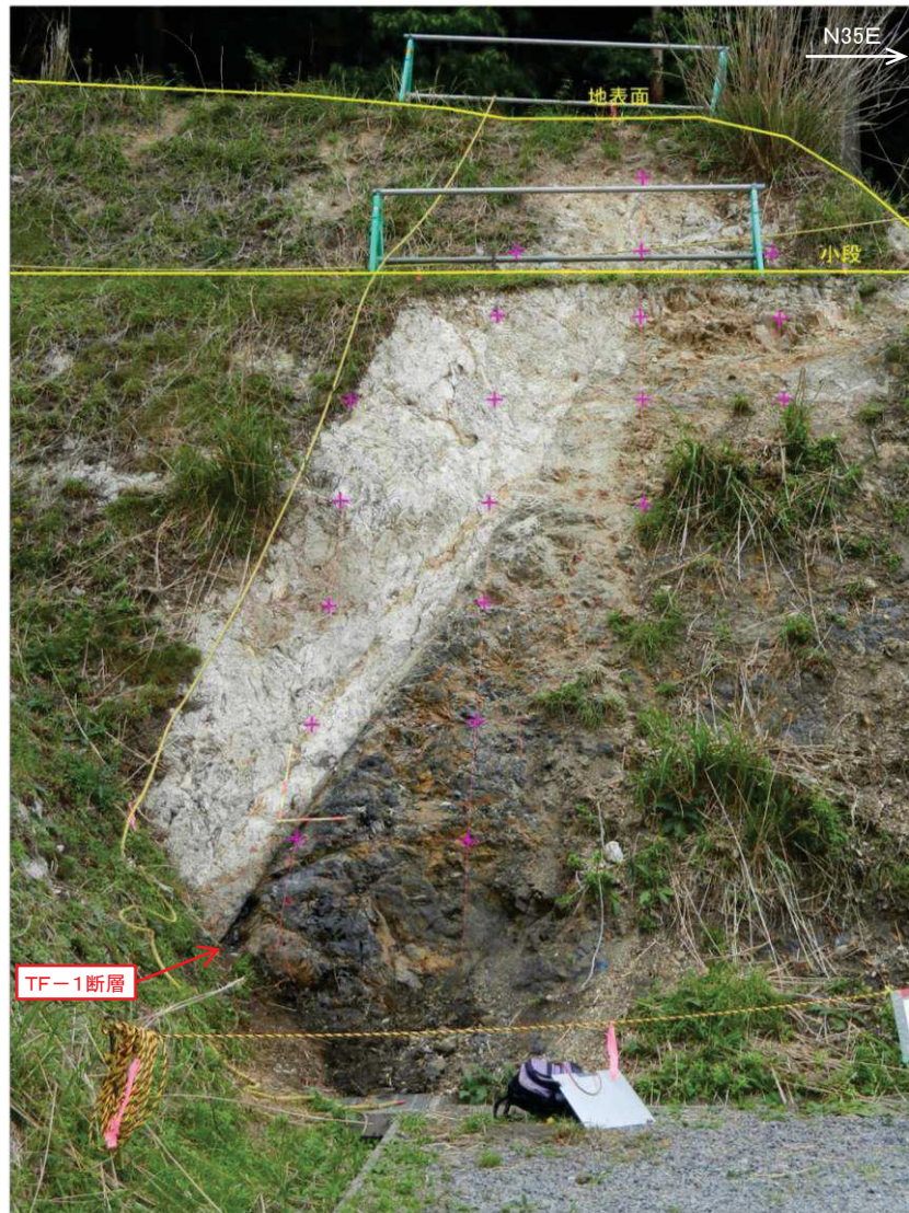
TF-1断層露頭写真
