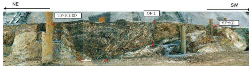
<観察法面の遠景>
