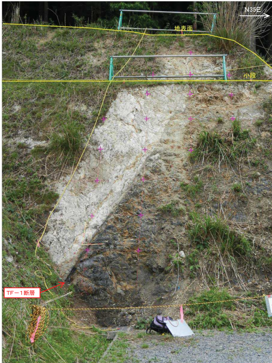
露頭写真(平成27年9月以前(撮影はH26.8))
