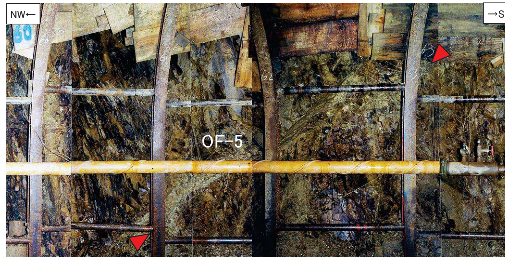
3号炉試掘坑1坑北東壁で確認したOF-5断層(下:写真, 右上:スケッチ)
