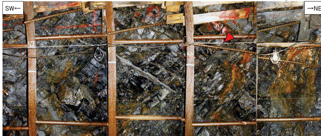
2号炉試掘坑B坑北西壁で確認したTF-3断層(下:写真, 右上:スケッチ)
