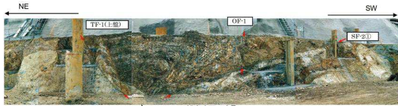
<観察法面の遠景>
