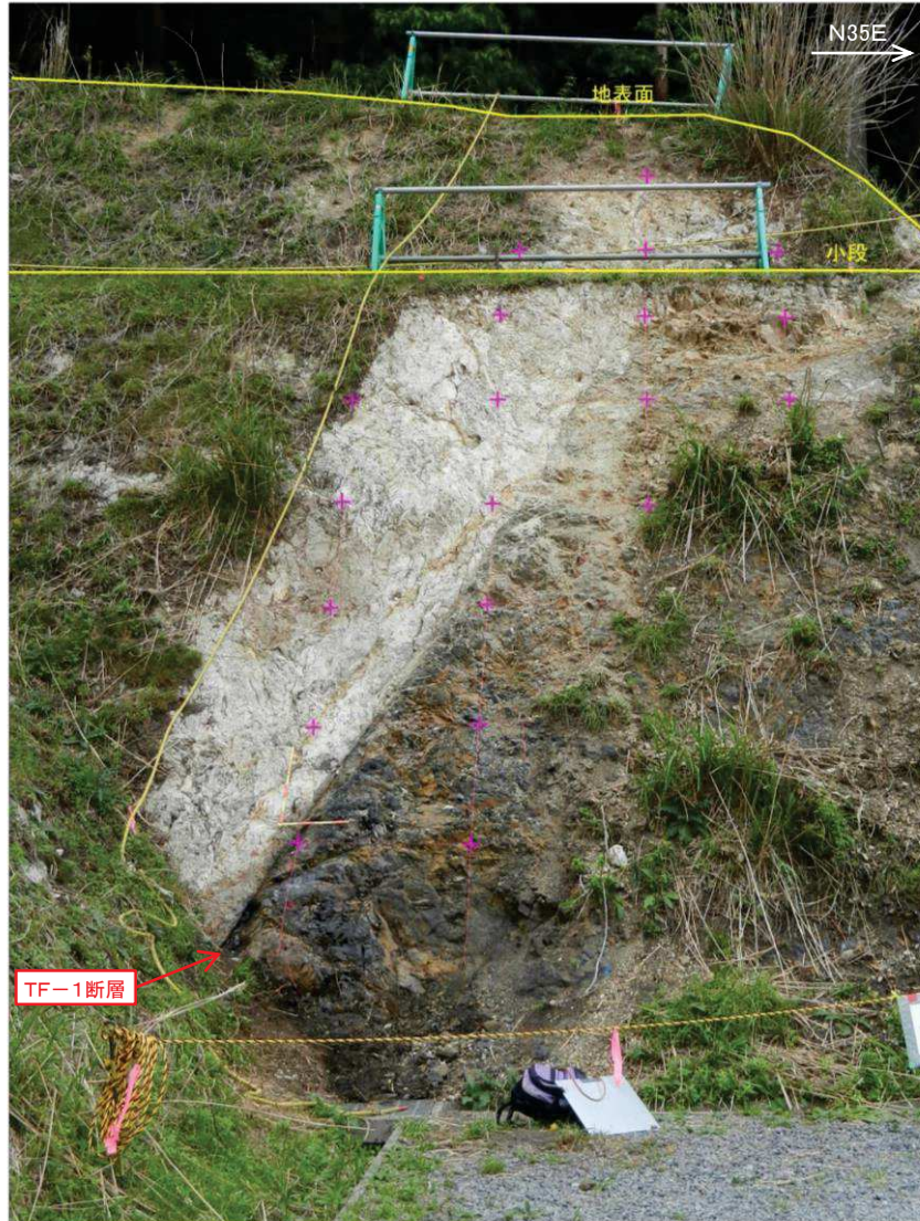
TF-1断層露頭写真
