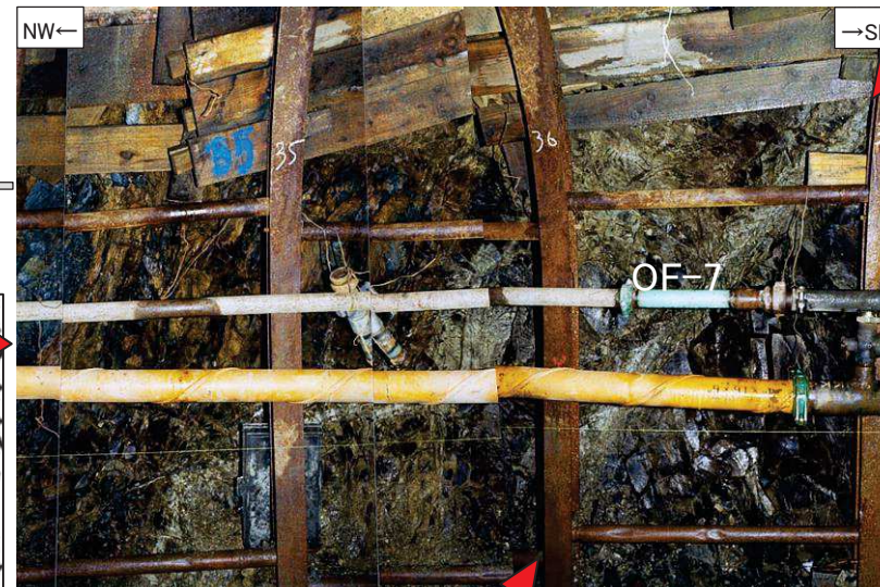
3号炉試掘坑1坑北東壁で確認したOF-7断層(右:写真, 左:スケッチ)
