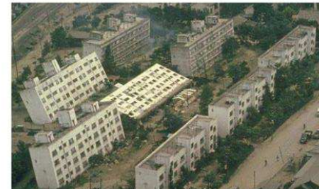
新潟地震で地盤の液状化現象により支持力を失って傾いた県営アパート※
