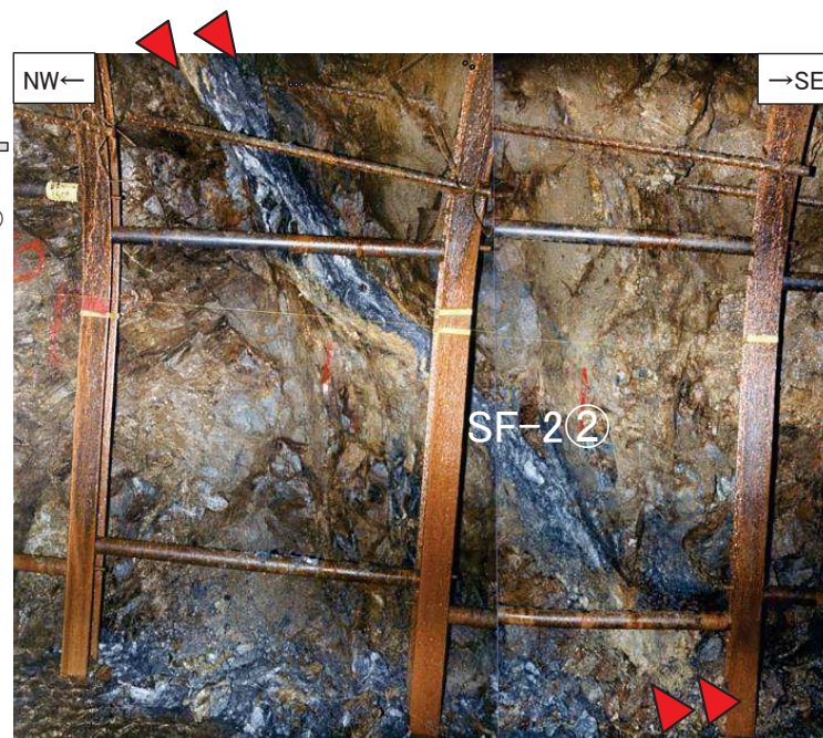
2号炉試掘坑A坑北東壁で確認したSF-2②断層(左:スケッチ, 右:写真)
