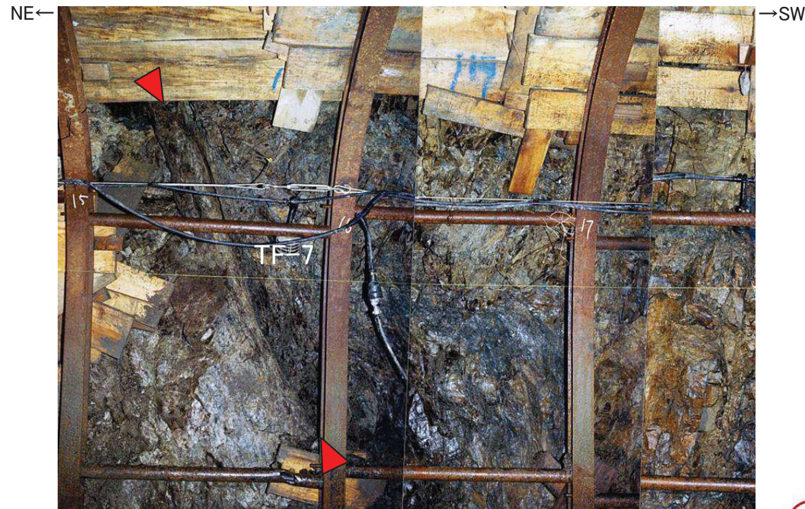
TF-7断層 3号炉試掘坑2号坑南東壁写真
