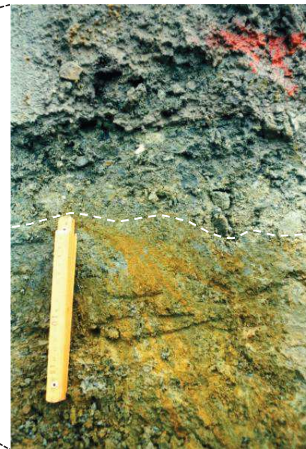
第四系基底と断層破碎帯の近接 (南側法面: 追い込み掘削前)
