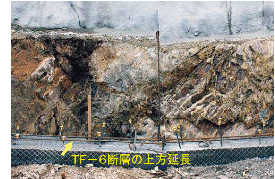
直掘部最上段のTF-6断層延長部 表面が白濁化した砂岩がロート状に分布するが、せん断面や破碎帯は認められない。
