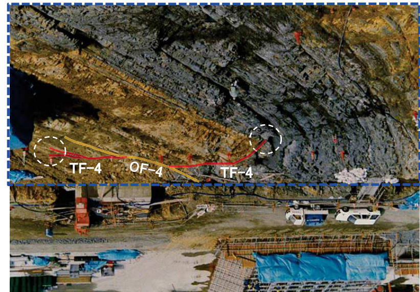
2号原子炉建屋掘削時の岩盤状況写真 (写真は天地を反転)
