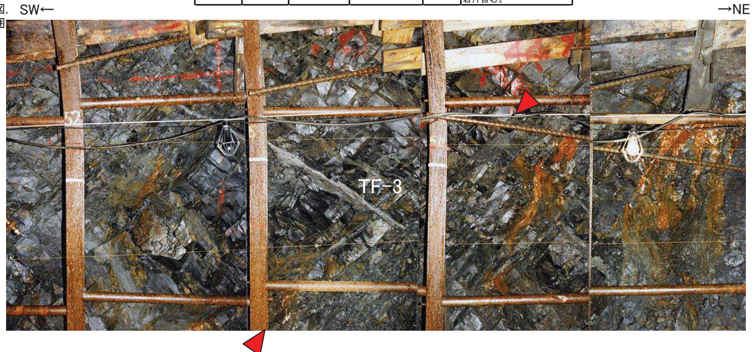
TF-3断層 2号炉試掘坑B坑北西壁写真
