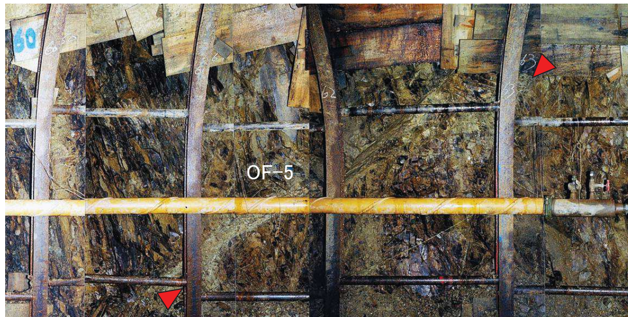
OF-5断層 3号炉試掘坑1号坑北東壁写真
