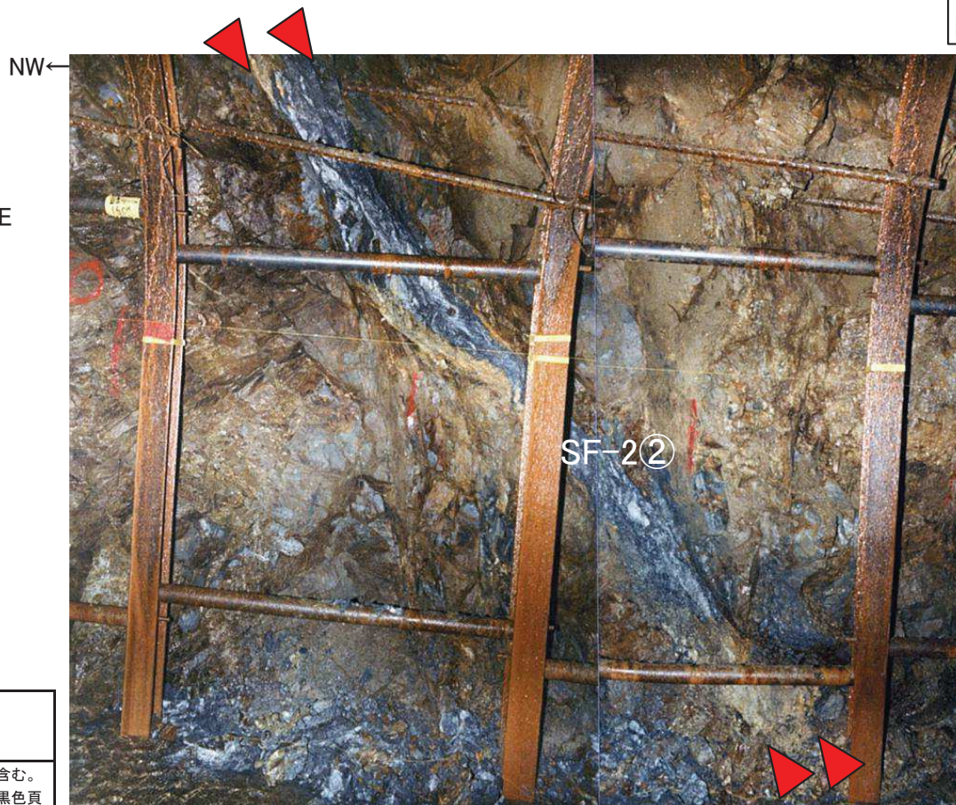
SF-2②断層 2号炉試掘坑A坑北東壁写真
