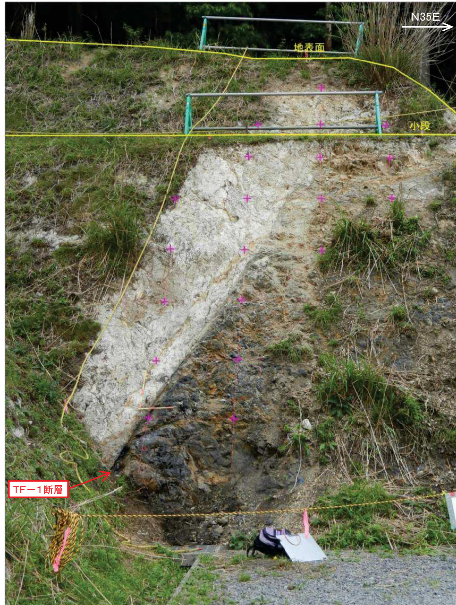
TF-1断層露頭写真
