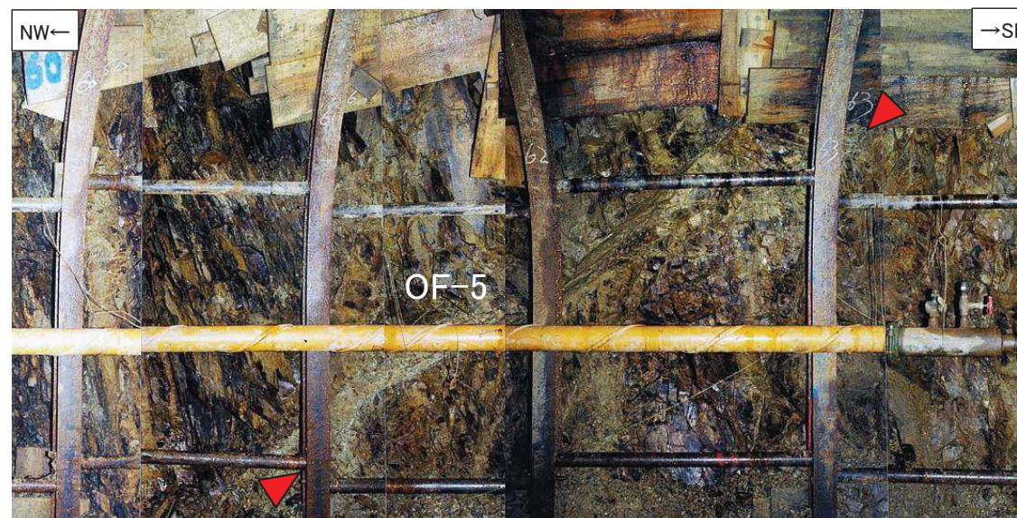
3号炉試掘坑1坑北東壁で確認したOF-5断層(下:写真, 右上:スケッチ)
