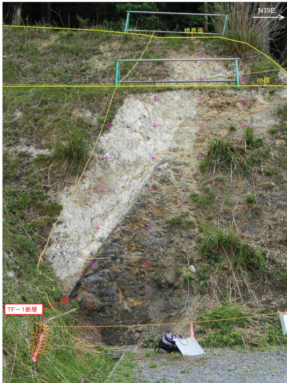
露頭写真(平成27年9月以前(撮影はH26.8))
