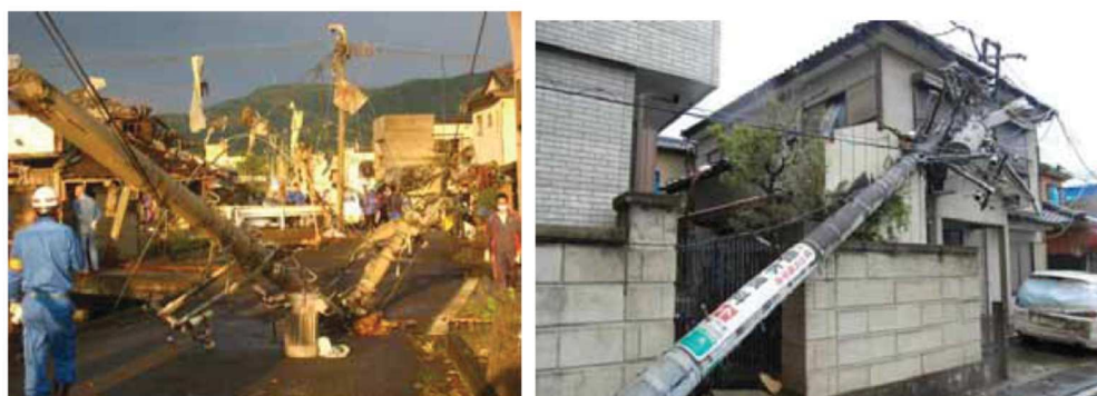
(電柱の折損, 傾斜)
