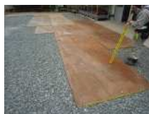
N5_敷き鉄板
