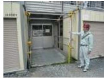
N4_仮設足場
