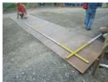
E3_敷き鉄板
