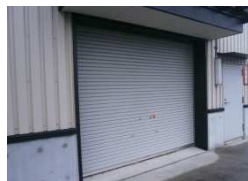
シャッター, 扉
