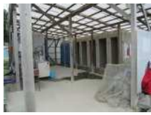
N5_仮設トイレ(1)
