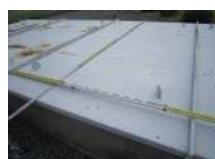
CS5_鋼製ハッチカバー (15)
