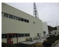
ガラス窓, 配管
