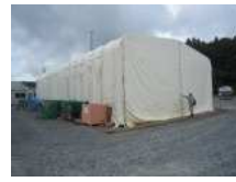
N5_テント倉庫
