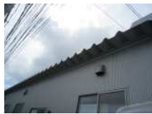
N4_折板屋根
