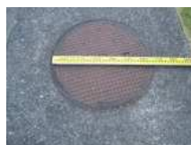
N5_マンホール蓋
