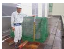
CS2_仮設足場板
