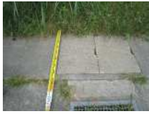
N2_コンクリート板(2)
