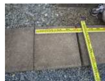
CS5_コンクリート板(1)
