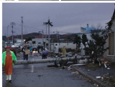
(電柱，道路標識の折損)
