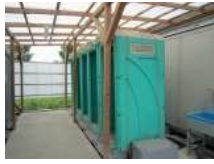
N4_仮設トイレ(3)
