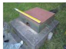
N5_鋼製カバー
