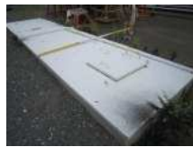
CS6_鋼製ハッチカバー
