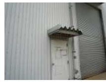
N3_折板屋根(3)
