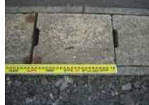
CS6_コンクリート板(2)
