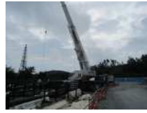
N1_ラフテレーンクレーン
