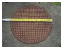
CS5_マンホール蓋(4)
