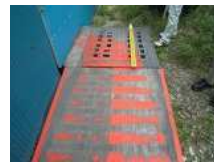
N3_仮設足場板
