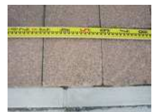
CS9_コンクリート板(3)
