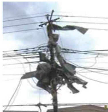
飛散した折板屋根の状況
