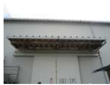
N3_折板屋根(4)
