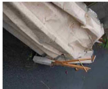
飛散した折板屋根の状況
