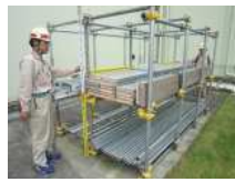
CS8_仮設足場(1)
