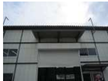
N5_折板屋根(1)
