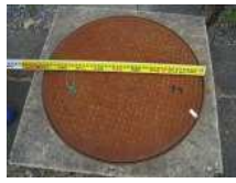
CS6_マンホール蓋(1)
