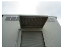
N3_折板屋根(2)
