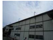
N5_折板屋根(2)
