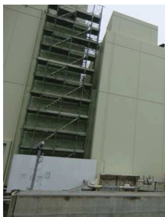
図 2 1 女川原子力発電所における仮設足場の状況
