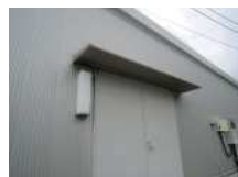
N4_鋼製屋根
