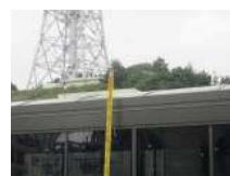
CN3_鋼製屋根
