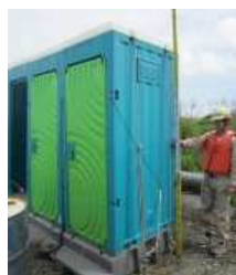
E3_仮設トイレ(2)
