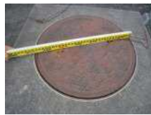
CS5_マンホール蓋(1)
