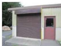
NE1_シャッター(1)
