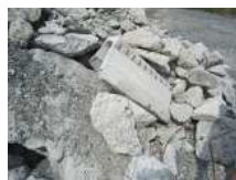
E4_コンクリート製U字溝
