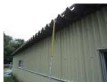
NE1_折板屋根
