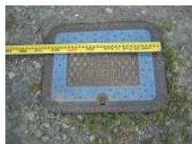
N4_マンホール蓋(2)
