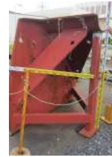
CS6_鋼製架台(3)
