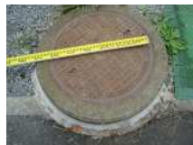
N2_マンホール蓋(1)
