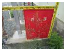
CN5_消火器格納庫(2)
