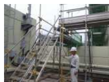
CS1_仮設足場
