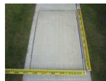
CS5_コンクリート板(2)
