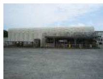
N5_テント倉庫
