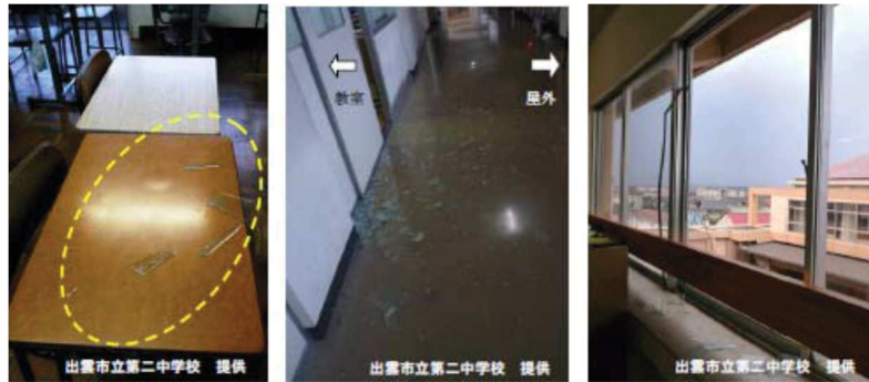
(1) 教室 (2) 廊下 (3) 屋外に面した窓ガラス
