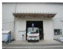
N3_折板屋根(5)
