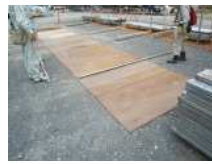
N1_敷き鉄板(2)
