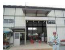
N5_折板屋根(3)
