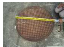
CS5_マンホール蓋(2)
