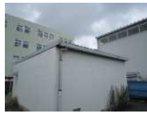
N3_折板屋根(1)
