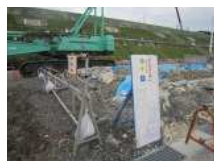
E2_鋼製看板
