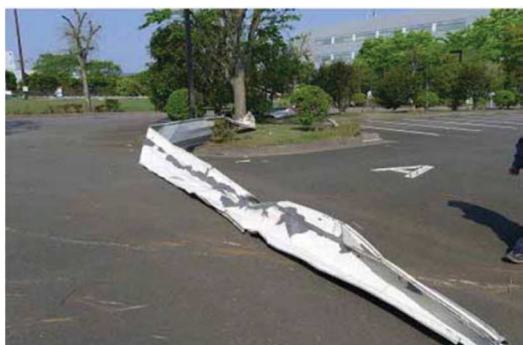
飛散した鋼板製屋根材
