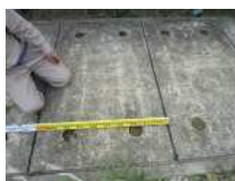
CS5_コンクリート板(6)
