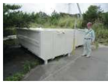
N2_鋼製容器
