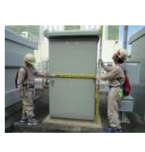
CS5_電気防食装置
