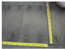
CS6_コンクリート板(1)
