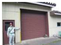
NE1_シャッター(2)
