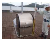
CS1_鋼製容器
