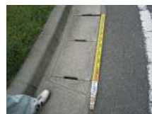
N4_コンクリート板
