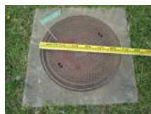
N2_マンホール蓋(2)
