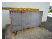
CS5_鋼製カバー(2)
