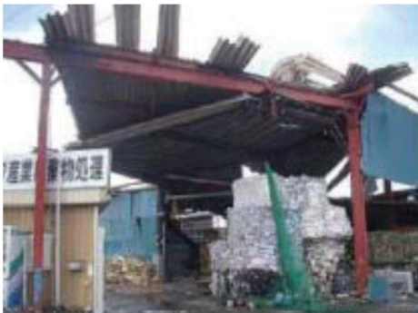
折板の損傷
