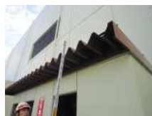
CS5_折板屋根
