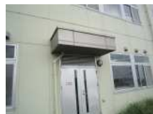
N2_鋼製屋根(1)
