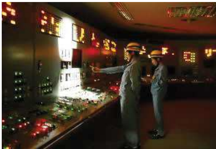
（シミュレータ施設におけるヘッドライト使用状況） 図 2.5-6 可搬型照明（ヘッドライト）使用イメージ
