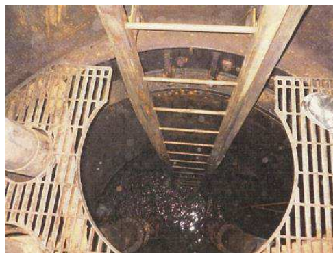
写真C 揚水井戸⑦(下段部) 2017/3/16撮影
