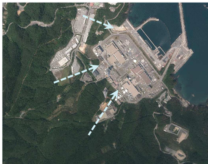
発電所周辺の空中写真(2011年撮影) (CTO20117 C28 23) 出典:国土地理院
