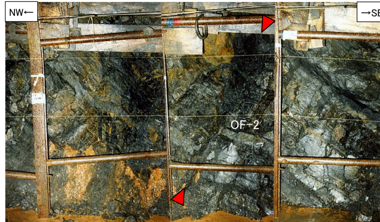
2号炉試験掘坑A坑北東壁で確認したOF-2断層(左:写真, 右:スケッチ)
