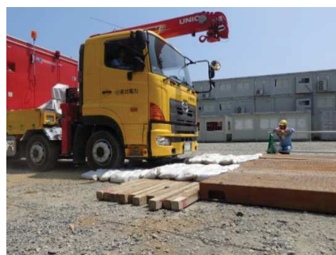
大型車両通行状況
