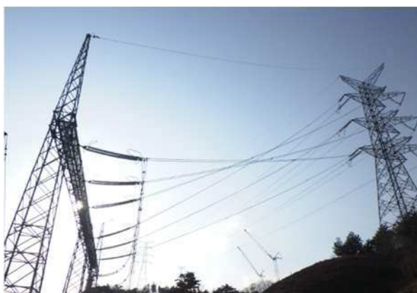
第7図 3号開閉所引留鉄構の架線状況
