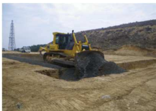
写真2 碎石運搬・埋め戻し状況
