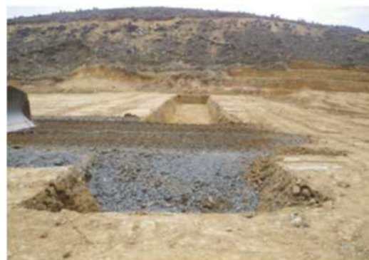
写真4 作業完了状況
