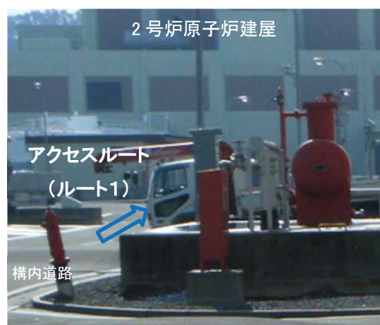
写真C:地震後の状況【平成23年3月12日撮影】
