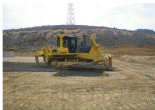
写真3 碎石運搬・埋め戻し状況
