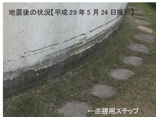
第 8 図 2011 年東北地方太平洋沖地震における沈下発生状況 (4 / 5)
