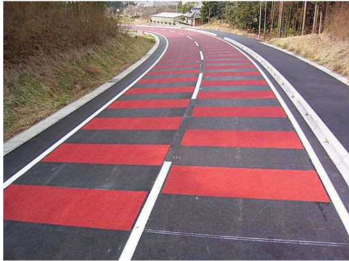
第2図 すべり止め舗装例
