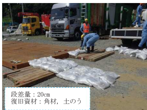
段差復旧作業状況
