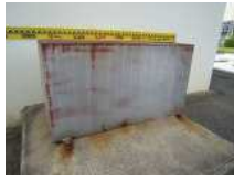
CS5_鋼製カバー(2)
