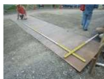
E3_敷き鉄板
