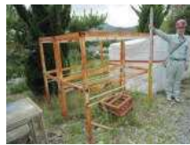
N3_鋼製フレーム(2)
