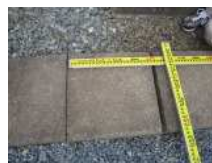
CS5_コンクリート板(1)
