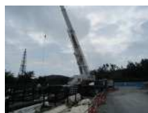
N1_ラフテレーンクレーン
