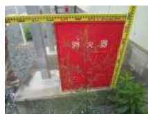
CN5_消火器格納庫(2)
