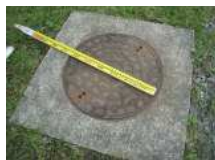
N4_マンホール蓋(1)
