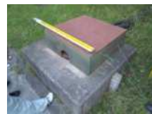
N5_鋼製カバー
