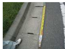
N4_コンクリート板
