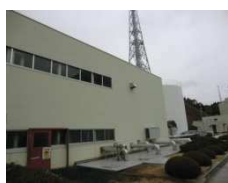
ガラス窓, 配管
