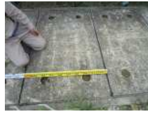
CS5_コンクリート板(6)
