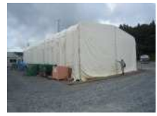
N5_テント倉庫
