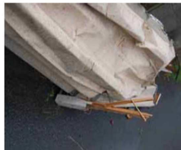
飛散した折板屋根の状況
