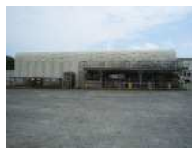
N5_テント倉庫
