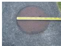
N5_マンホール蓋
