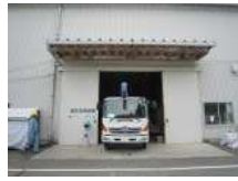
N3_折板屋根(5)
