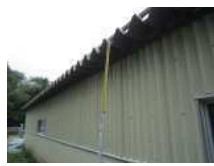
NE1_折板屋根
