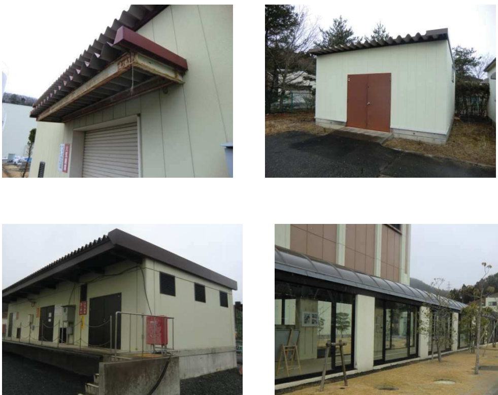
図18 女川原子力発電所における屋外屋根の状況
