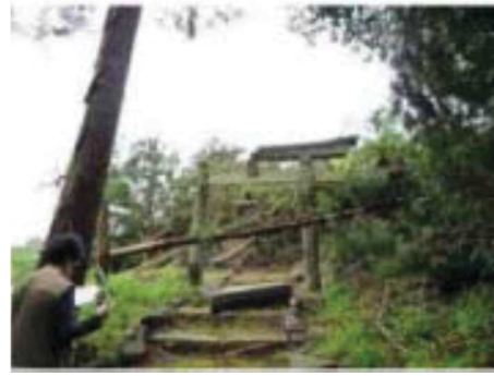
倒木の折損と鳥居の被害
