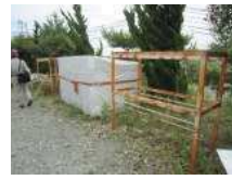
N3_鋼製フレーム(1)
