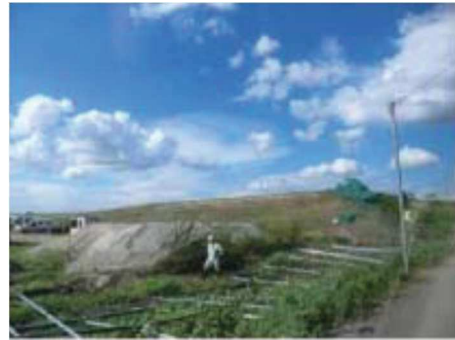
フェンスの被害
