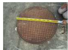
CS5_マンホール蓋(2)
