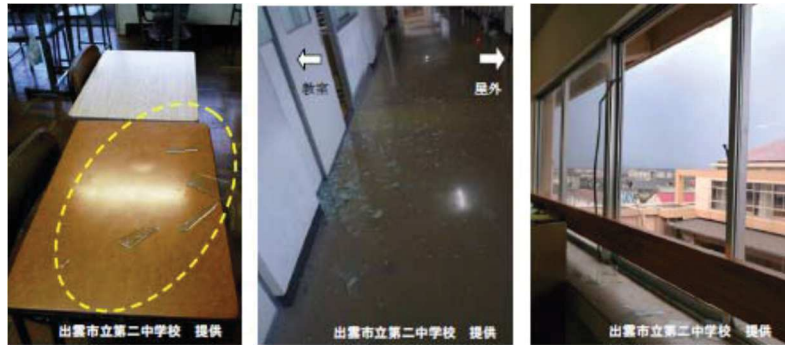
(1) 教室 (2) 廊下 (3) 屋外に面した窓ガラス
