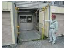
N4_仮設足場
