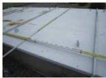
CS5_鋼製ハッチカバー (15)
