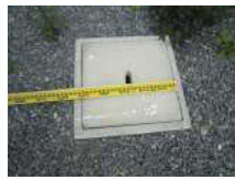
CS8_コンクリート板(1)
