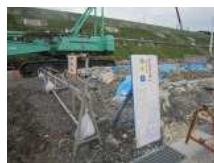
E2_鋼製看板
