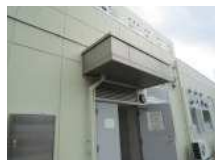
N2_鋼製屋根(2)
