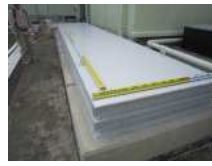
CS5_鋼製ハッチカバー(3)
