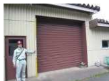
NE1_シャッター(2)
