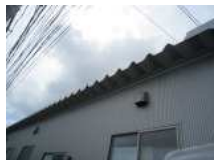
N4_折板屋根
