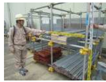
CS8_仮設足場(2)
