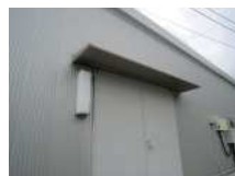
N4_鋼製屋根
