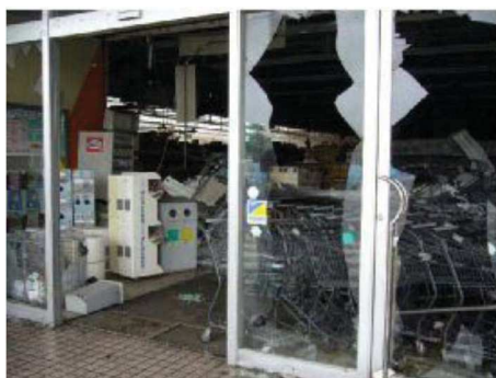
エントランスの窓ガラスの破損
