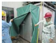
N3_鋼製物置(5)
