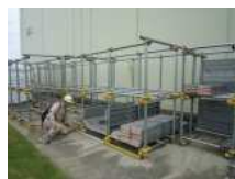
CS8_仮設足場(3)
