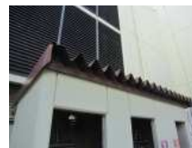
CS9_折板屋根
