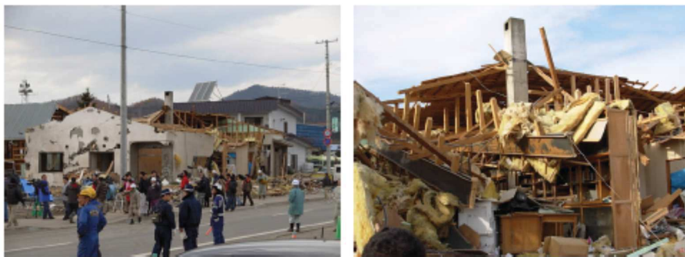
(電柱の折損，傾斜)
