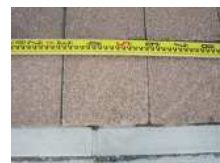
CS9_コンクリート板(3)
