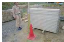
E1_仮設足場板(2)
