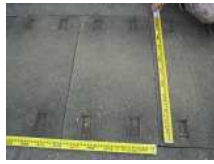
CS6_コンクリート板(1)
