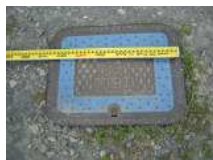
N4_マンホール蓋(2)
