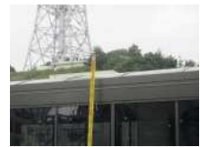
CN3_鋼製屋根
