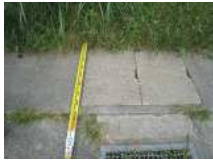
N2_コンクリート板(2)
