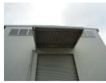
N3_折板屋根(2)
