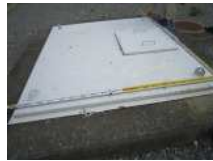
CS5_鋼製ハッチカバー (14)
