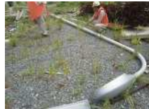
E4_屋外照明
