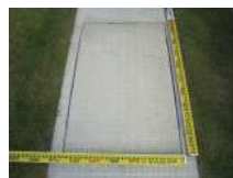
CS5_コンクリート板(2)
