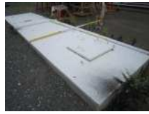
CS6_鋼製ハッチカバー
