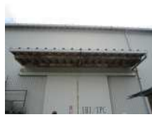
N3_折板屋根(4)
