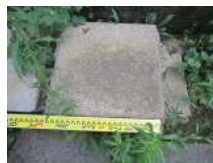
CS9_コンクリート板(4)
