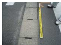
N2_コンクリート板(1)
