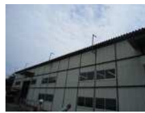
N5_折板屋根(2)
