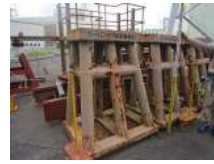
CS6_鋼製架台(2)
