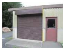
NE1_シャッター(1)
