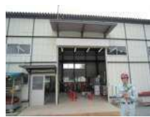
N5_折板屋根(3)
