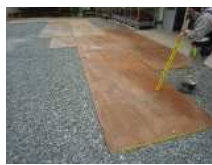
N5_敷き鉄板
