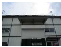
N5_折板屋根(1)
