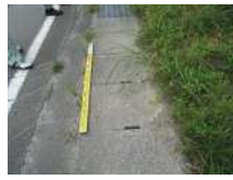
N3_コンクリート板
