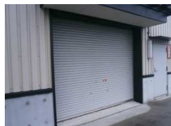
シャッター, 扉
