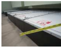
CS5_鋼製ハッチカバー(2)
