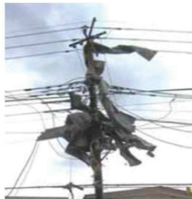
飛散した折板屋根の状況
