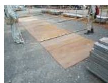
N1_敷き鉄板(2)
