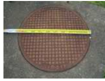
CS5_マンホール蓋(4)
