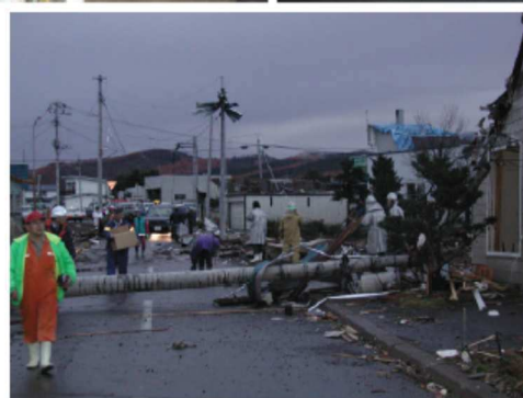
(電柱，道路標識の折損)
