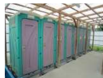
N4_仮設トイレ(2)
