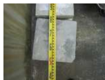
CS9_コンクリート板(5)
