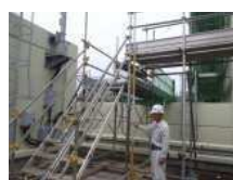
CS1_仮設足場
