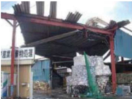
折板の損傷
