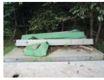
NE1_コンクリート製容器 (2)
