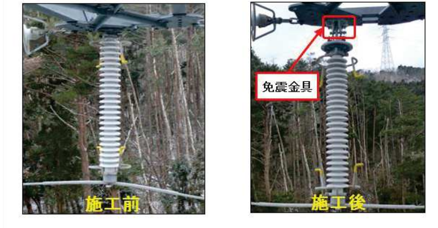
第 2. 2. 4-9 図 免震金具取付の施工状況
