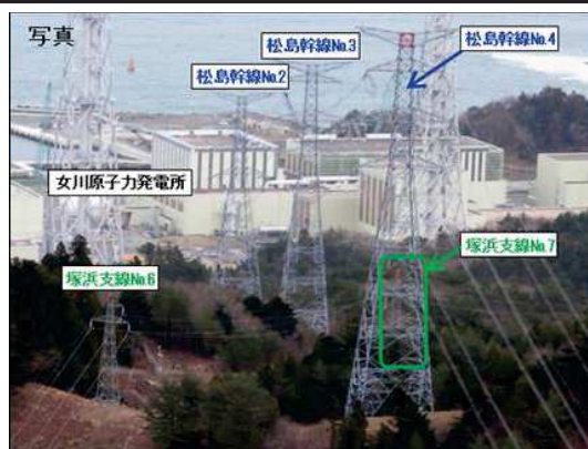
第 2. 2. 3-3 図 ①交差箇所の現地状況
