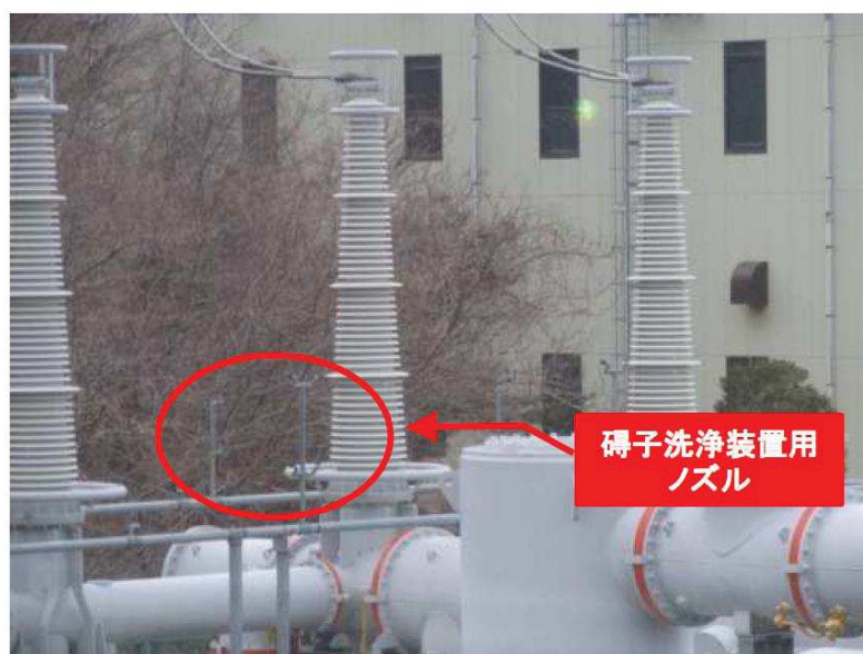
第 2.2.4-36 図 碍子洗浄装置外観
