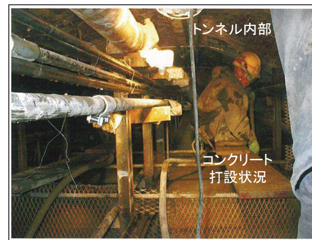
写真 施工状況写真
