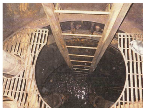
写真C 揚水井戸⑦(下段部) 2017/3/16撮影
