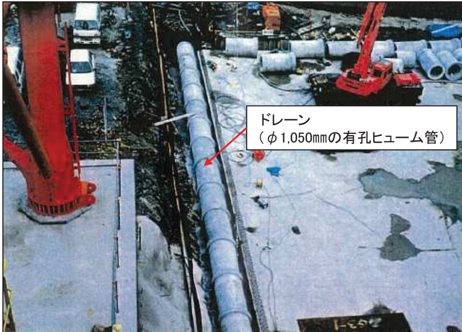
写真3-1 2号炉原子炉建屋北側 ドレーン(φ1,050mmの有孔ヒューム管)
