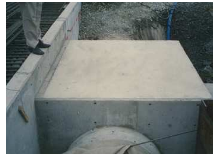
写真3-4 2号炉原子炉建屋周囲接続桧の例
