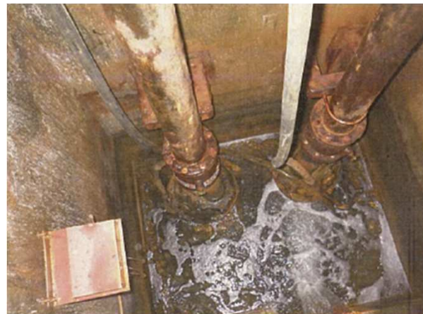
写真D 揚水井戸⑤(下段部) 2017/3/17撮影
