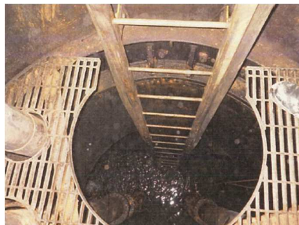
写真C 揚水井戸⑦(下段部) 2017/3/16撮影
