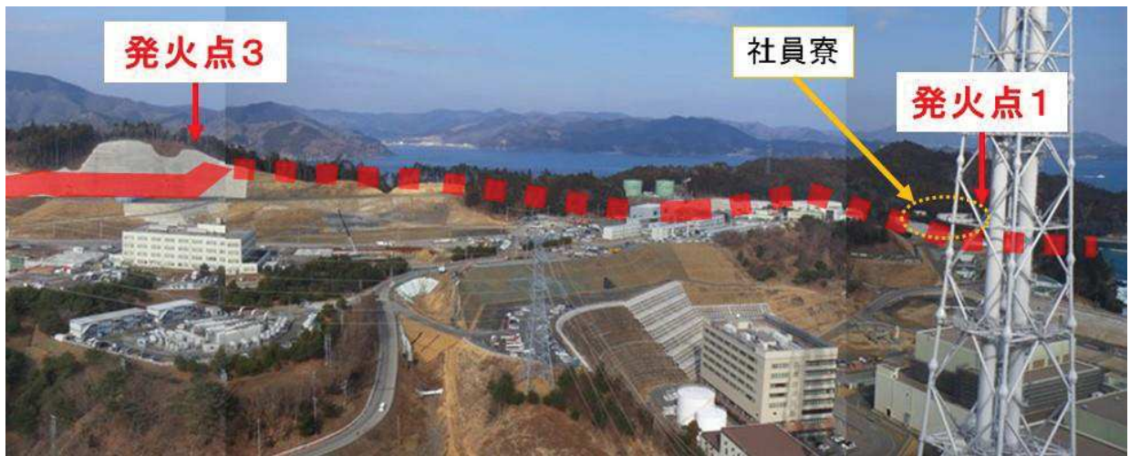
第 2.3.1.2-3 図 自然現象監視カメラ（北側監視）視野と発火点の位置
