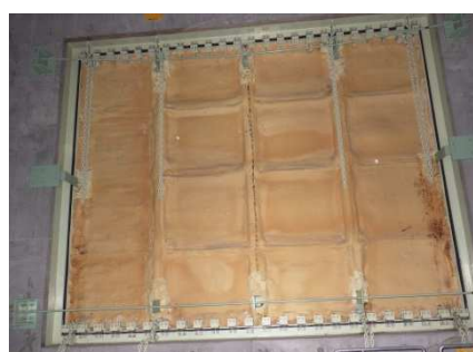
BOP外観（建屋内から撮影）
