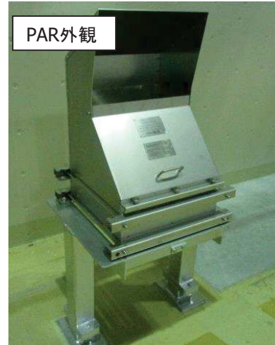
静的触媒式水素再結合装置
