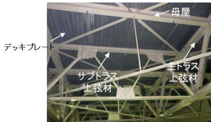
第 5.6.5-2 図 原子炉建屋原子炉棟天井の状況
